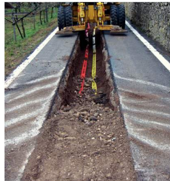
ALTO GARDA SERVIZI Posa sottoservizi Riva del Garda/Arco (Tn)
