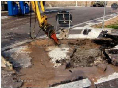
Bonifica Cisterne ADS Laimburg ovest - Bolzano
