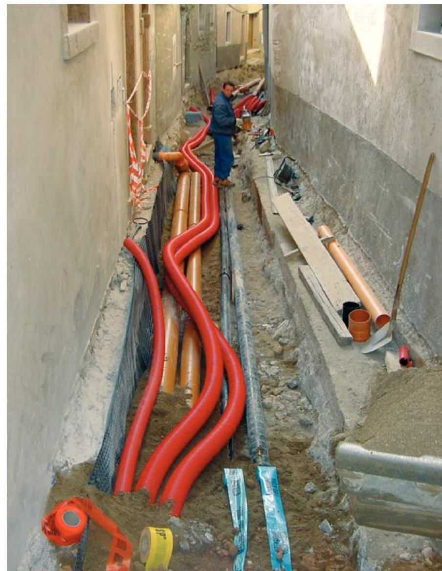
COMUNE DI TENNO Posa sottoservizi Cologna - Tenno (Tn)
