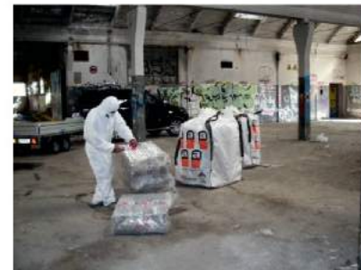
Cantiere ex Bimac Rovereto (TN)
