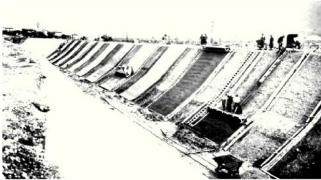
COSTRUZIONE CANALE BIFFIS Anni '40
