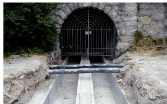
ENEL Posa sottoservizi e cunicolo Riva del Garda (Tn)
