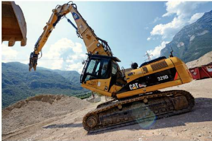
Escavatore da demolizione con braccio da 23 metri
