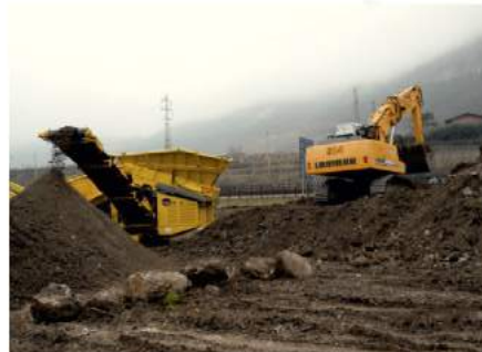
Hydro Dolomiti Enel Bonifica terreno
