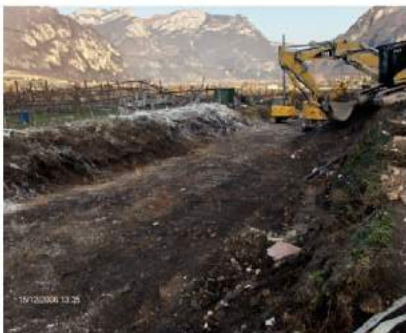
INTERVENTO DI BONIFICA F.S. Sinistro del 13/12/2006, Borghetto - Avio (Tn)
