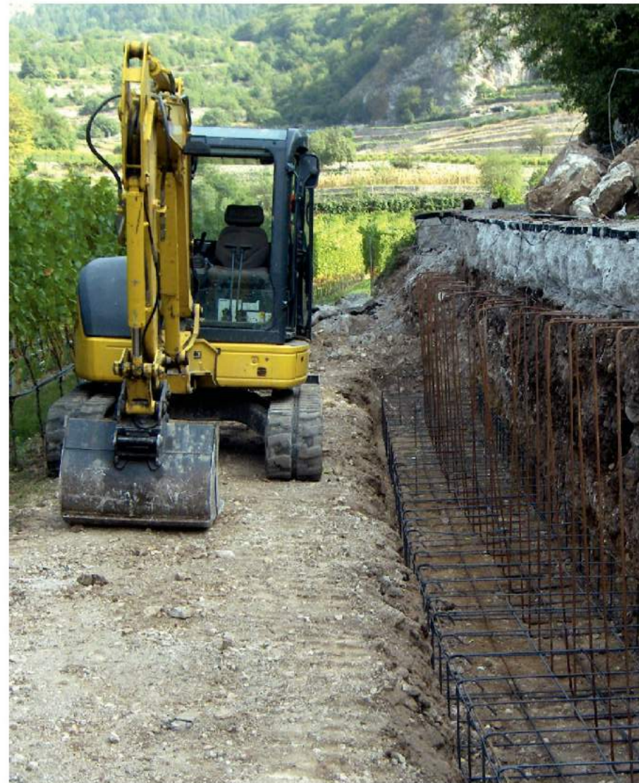
Consorzio miglioramento fondiario Valle San Felice - sistemazione strade rurali
