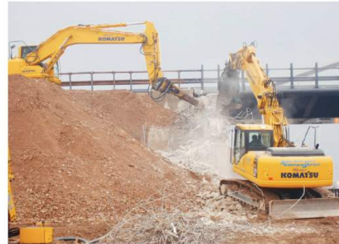
Demolizione Sovrapasso A22 - Nogaro/Rocca (Vr)
