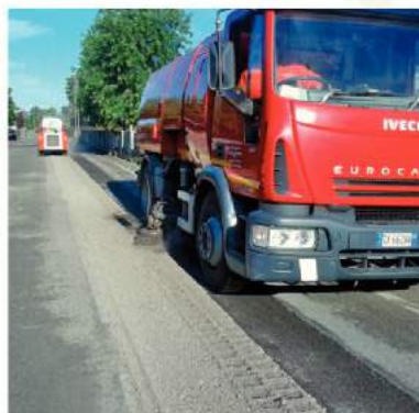
ETRA S.P.A. Attività di ripristino delle pavimentazioni stradali
