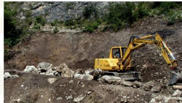
P.A.T. FORESTALE Costruzione strade Val de le Boire - Avio (Tn)
