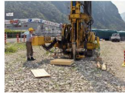
Caratterizzazione del sottosuolo. F.S. Borghetto, Avio (Tn) - Sinistro del 13/12/2006
