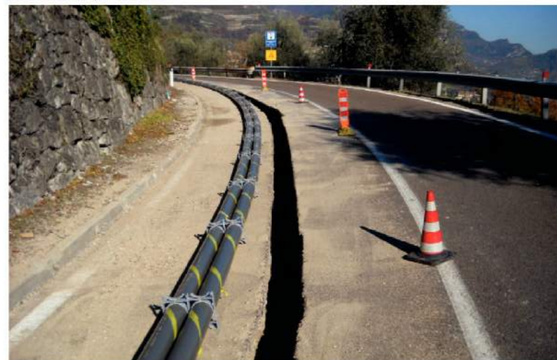
Alto Garda Servizi Scavo con fresa per posa sottoservizi
