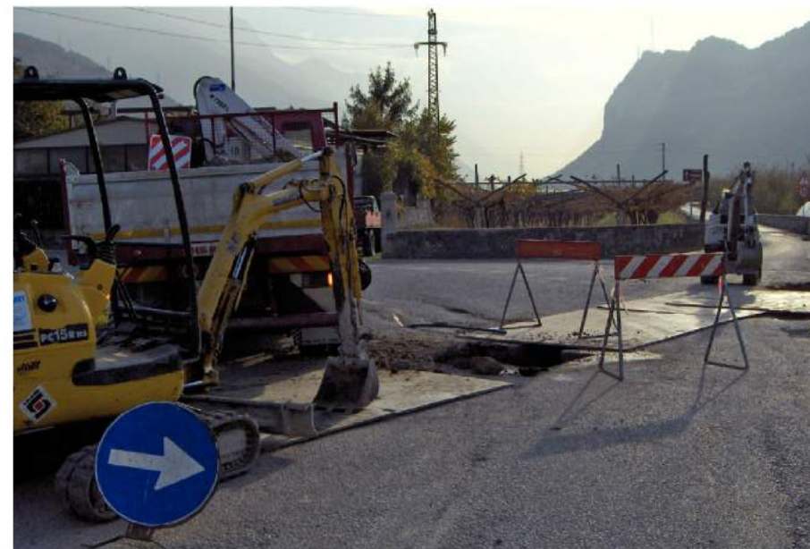
ALTO GARDA SERVIZI Posa sottoservizi Riva del Garda/Arco (Tn)
