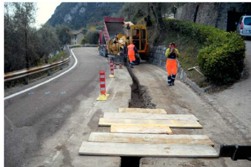
Alto Garda Servizi Scavo con fresa per posa sottoservizi
